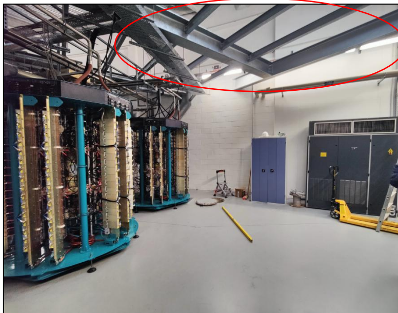
Poutres existantes à renforcer
